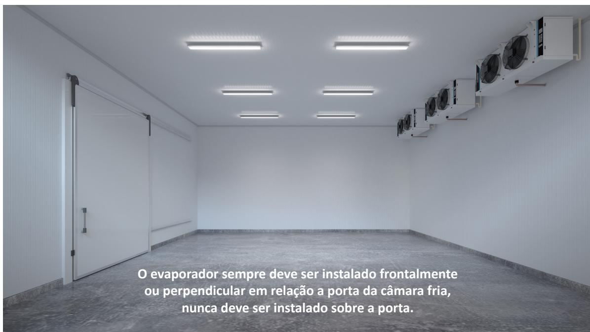
Quando dois ou mais evaporadores DR são instalados lado a lado na câmara fria, o espaço entre eles deveria ser de no mínimo 0,5m para facilitar e viabilizar a manutenção. Como medida de segurança, recomenda-se que  $X_1 + Y_1$  seja menor ou igual a medida da flecha de ar do evaporador.
